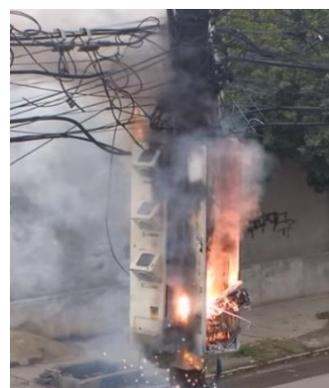
Figura 2: curto-circuito em um transformador de poste.
